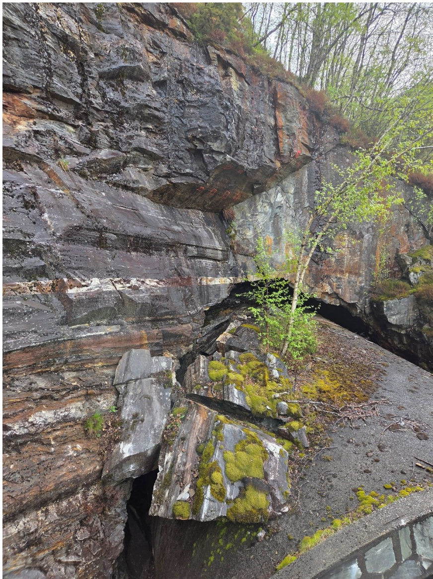
Figur 5. Sikring av utgåande sprekkeplan med større volum. Legg merke til eldre utfall langs disse sprekkeplana nærast i foto. I alt er det merka 8 boltar her av 4 meter lengd.
